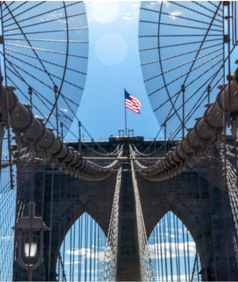
■ Vista desde el interior del puente de Brooklyn, símbolo de acceso, conexión y justicia pública en la ciudad de Nueva York.
